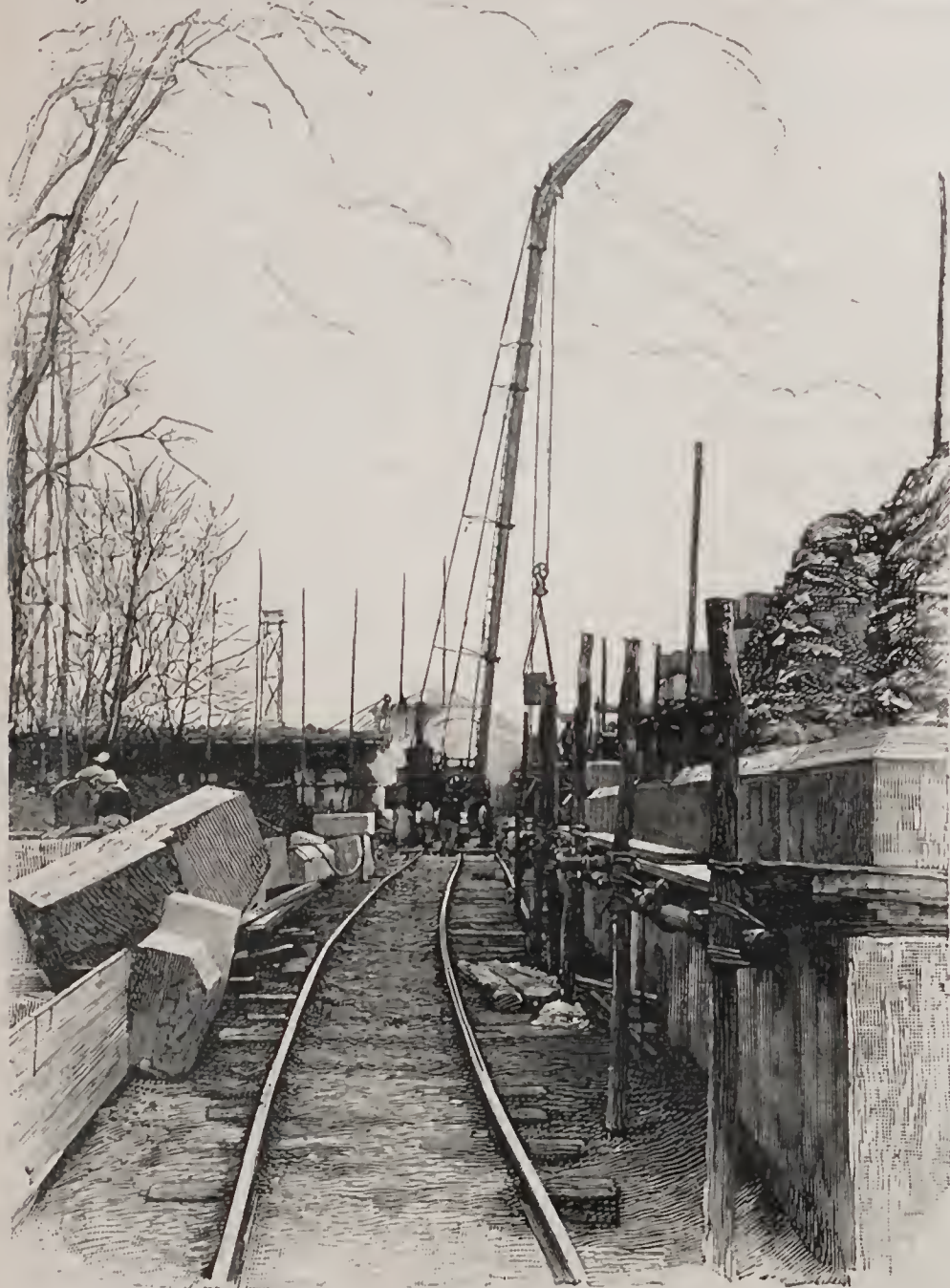
LES CHANTIERS DES CHAMPS-ÉLYSÉES. — Le grand élévateur à bras mobiles.
